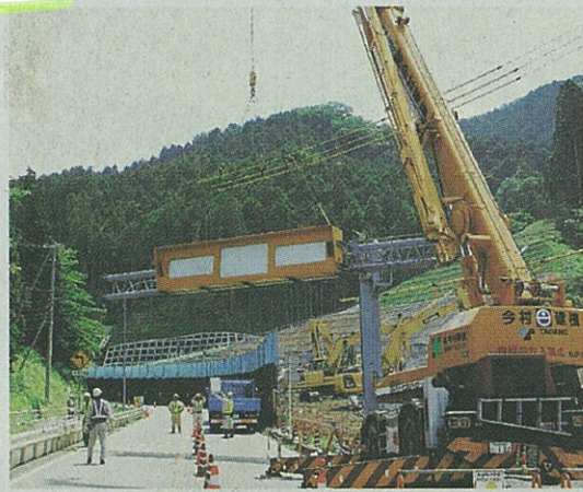
通行止め装置を撤去する作業員
